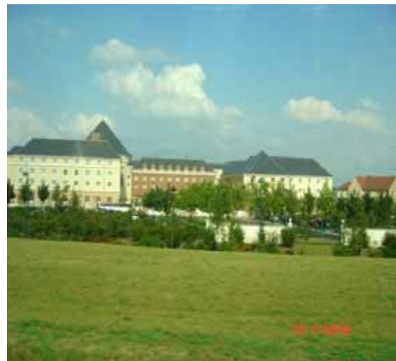
단지내 호텔 전경
