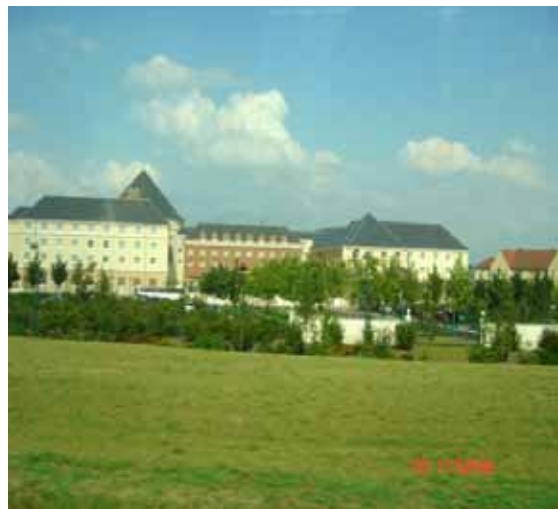
단지내 호텔 전경
