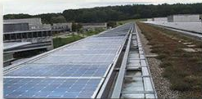
태양열을 이용한 대학건물 (스위스 ETH)
