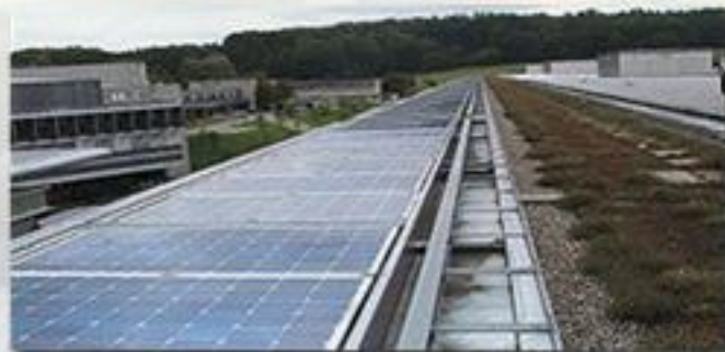
태양열을 이용한 대학건물 (스위스 ETH)
