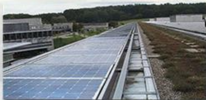
태양열을 이용한 대학건물 (스위스 ETH)
