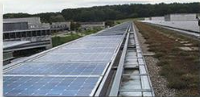
태양열을 이용한 대학건물 (스위스 ETH)
