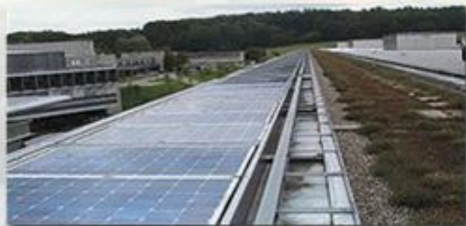
태양열을 이용한 대학건물 (스위스 ETH)
