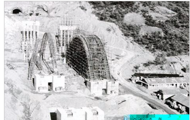
경부고속도로 공사 현장
