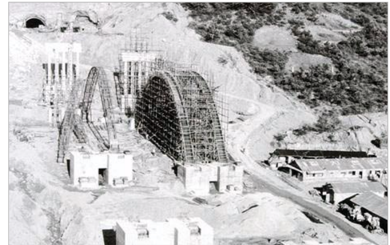
경부고속도로 공사 현장
