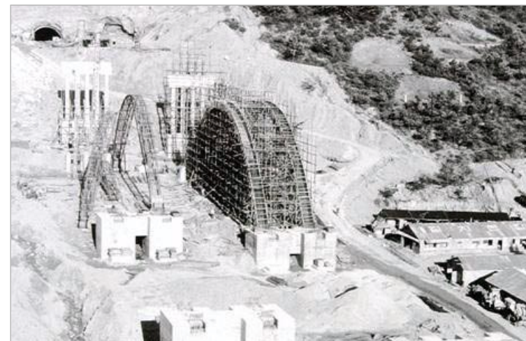
경부고속도로 공사 현장
