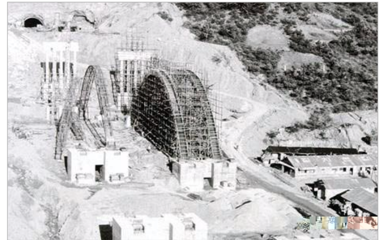
경부고속도로 공사 현장
