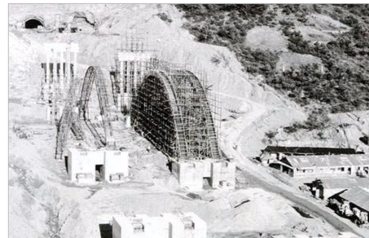
경부고속도로 공사 현장
