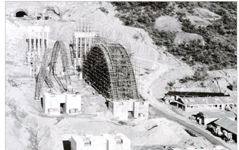
경부고속도로 공사 현장
