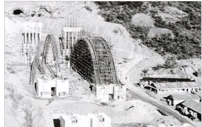
경부고속도로 공사 현장
