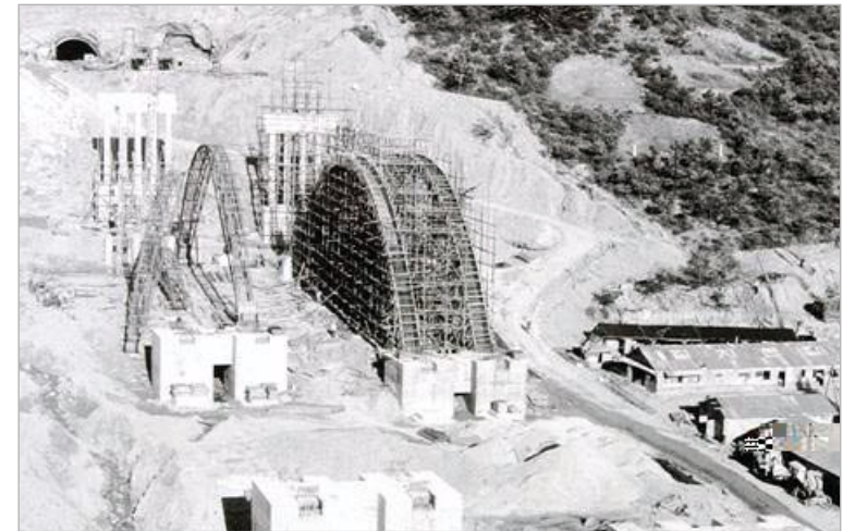
경부고속도로 공사 현장
