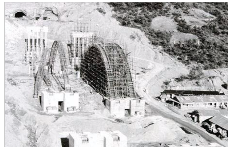
경부고속도로 공사 현장
