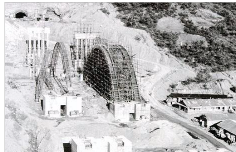
경부고속도로 공사 현장
