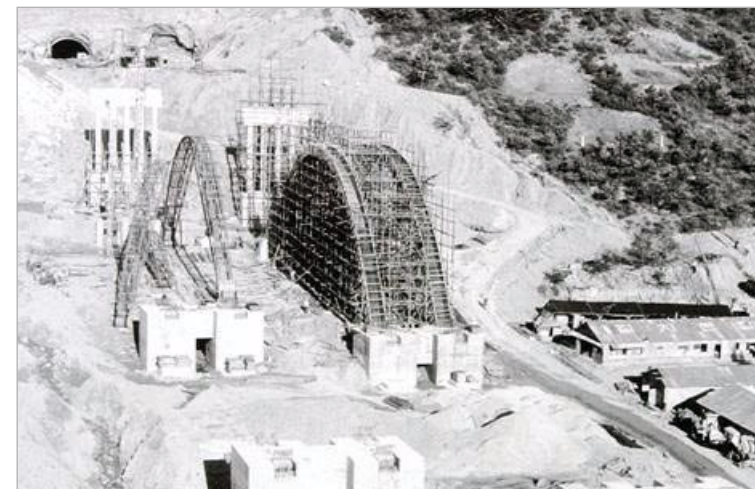
경부고속도로 공사 현장
