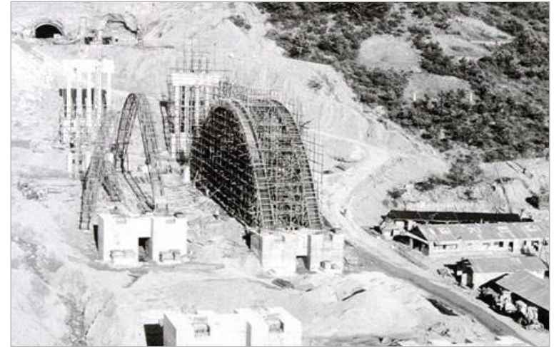
경부고속도로 공사 현장
