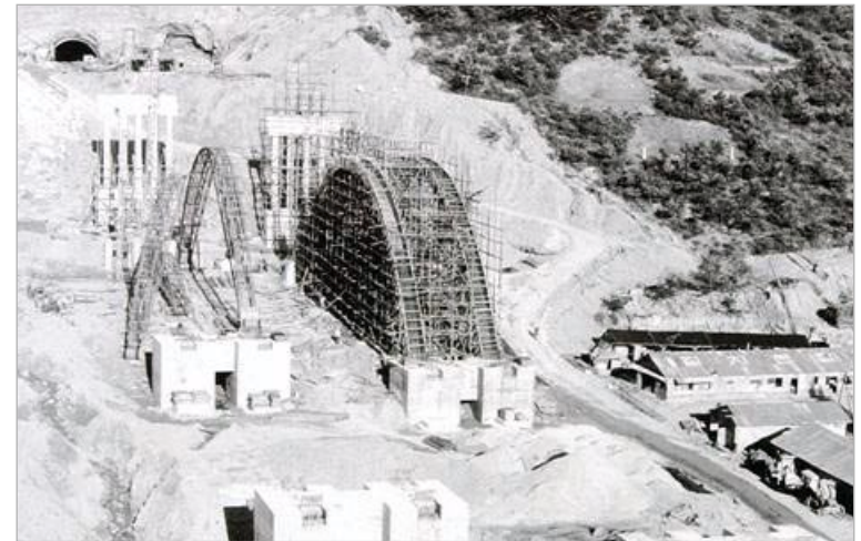
경부고속도로 공사 현장
