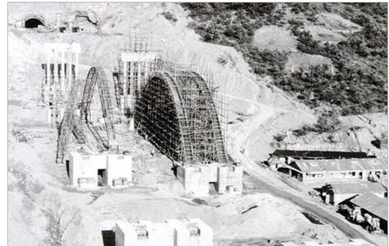
경부고속도로 공사 현장
