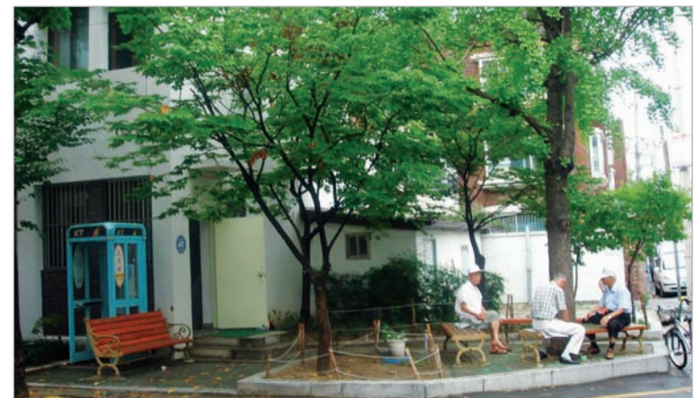
동사무소 담장 허물기
