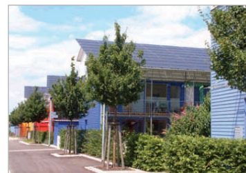
슐리어베르크의 태양광 연립주택
