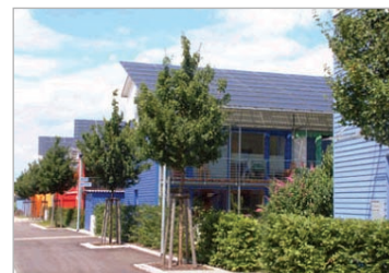
슐리어베르크의 태양광 연립주택
