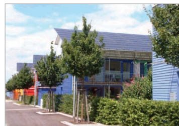
슐리어베르크의 태양광 연립주택
