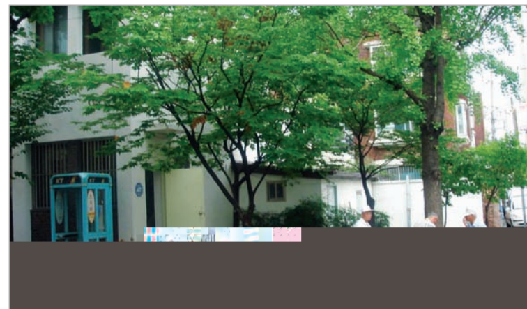
동사무소 담장 허물기
