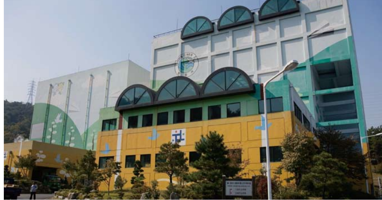
▲창원시와 마산시가 공동 사용하는 창원시 생활폐기물 소각장
