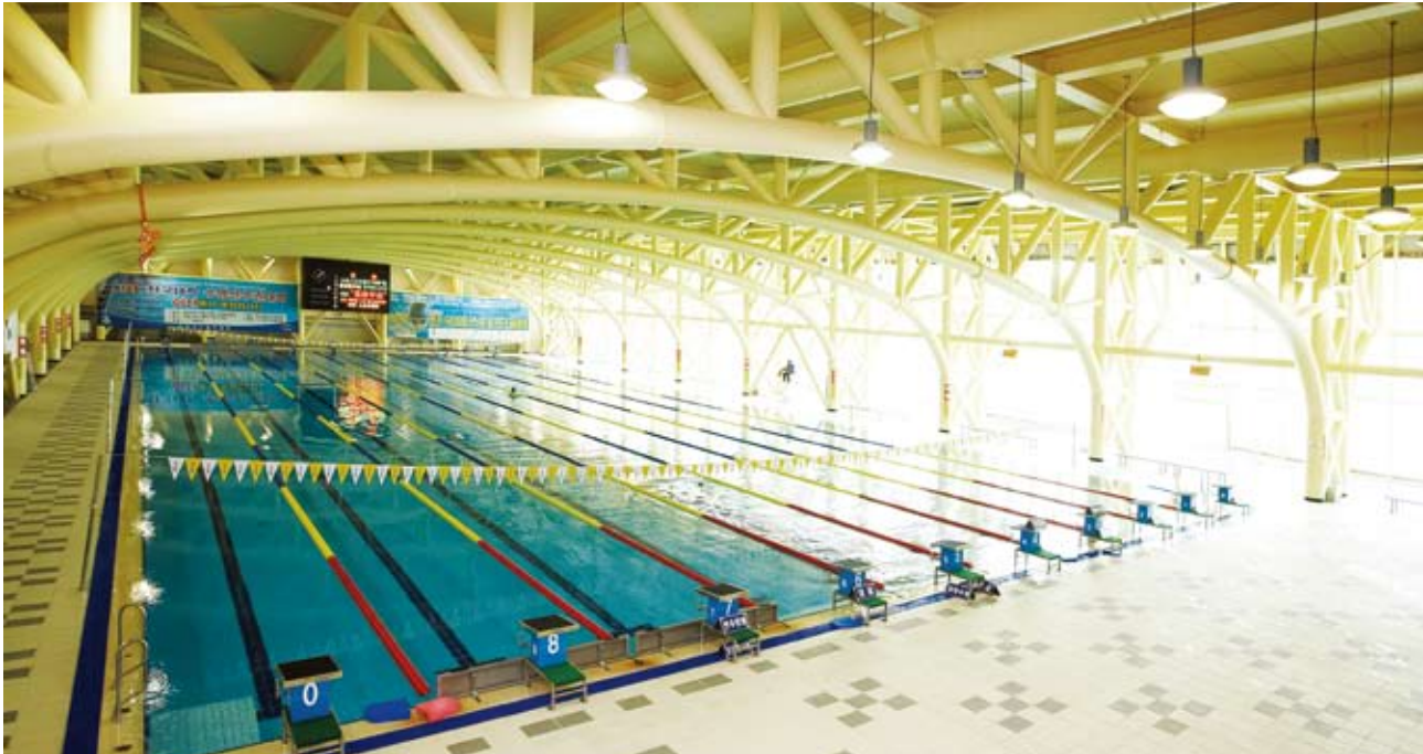
▲소각열을 이용한 이천스포츠클럽의 수영장
