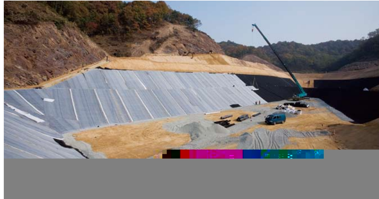
▲2010년 완공을 목표로 공사 중인 진천·음성 광역폐기물종합처리장
