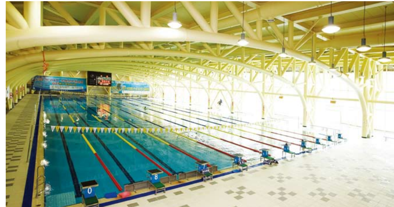
▲소각열을 이용한 이천스포츠클럽의 수영장
