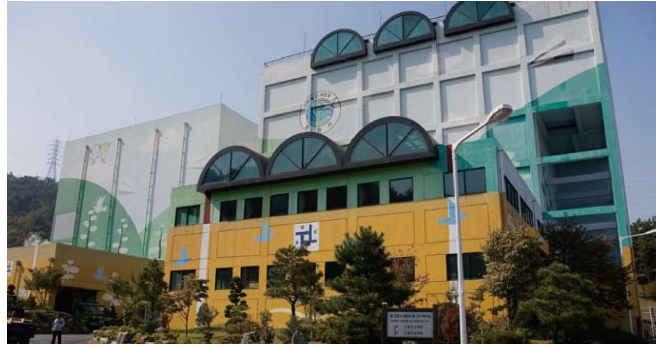
▲창원시와 마산시가 공동 사용하는 창원시 생활폐기물 소각장
