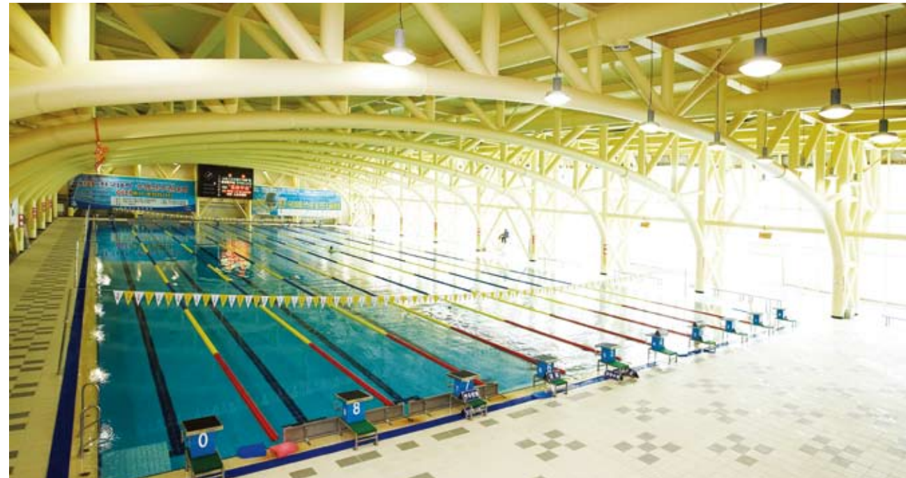
▲소각열을 이용한 이천스포츠허브의 수영장
