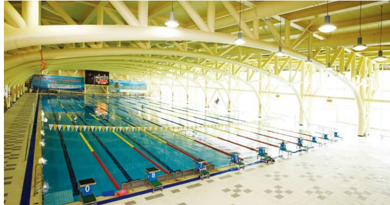
▲소각열을 이용한 이천스포츠허브의 수영장
