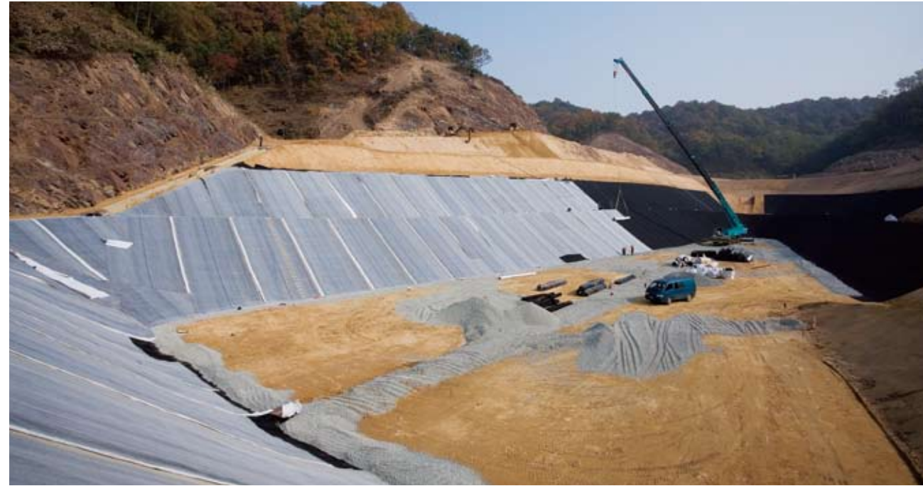
▲2010년 완공을 목표로 공사 중인 진천·음성 광역폐기물종합처리장
