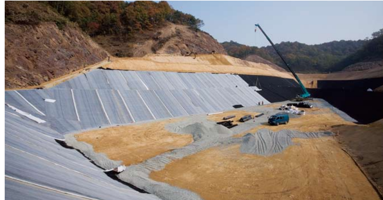
▲2010년 완공을 목표로 공사 중인 진천·음성 광역폐기물종합처리장
