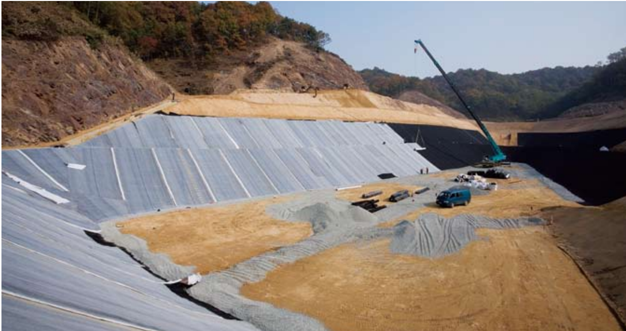
▲2010년 완공을 목표로 공사 중인 진천·음성 광역폐기물종합처리장
