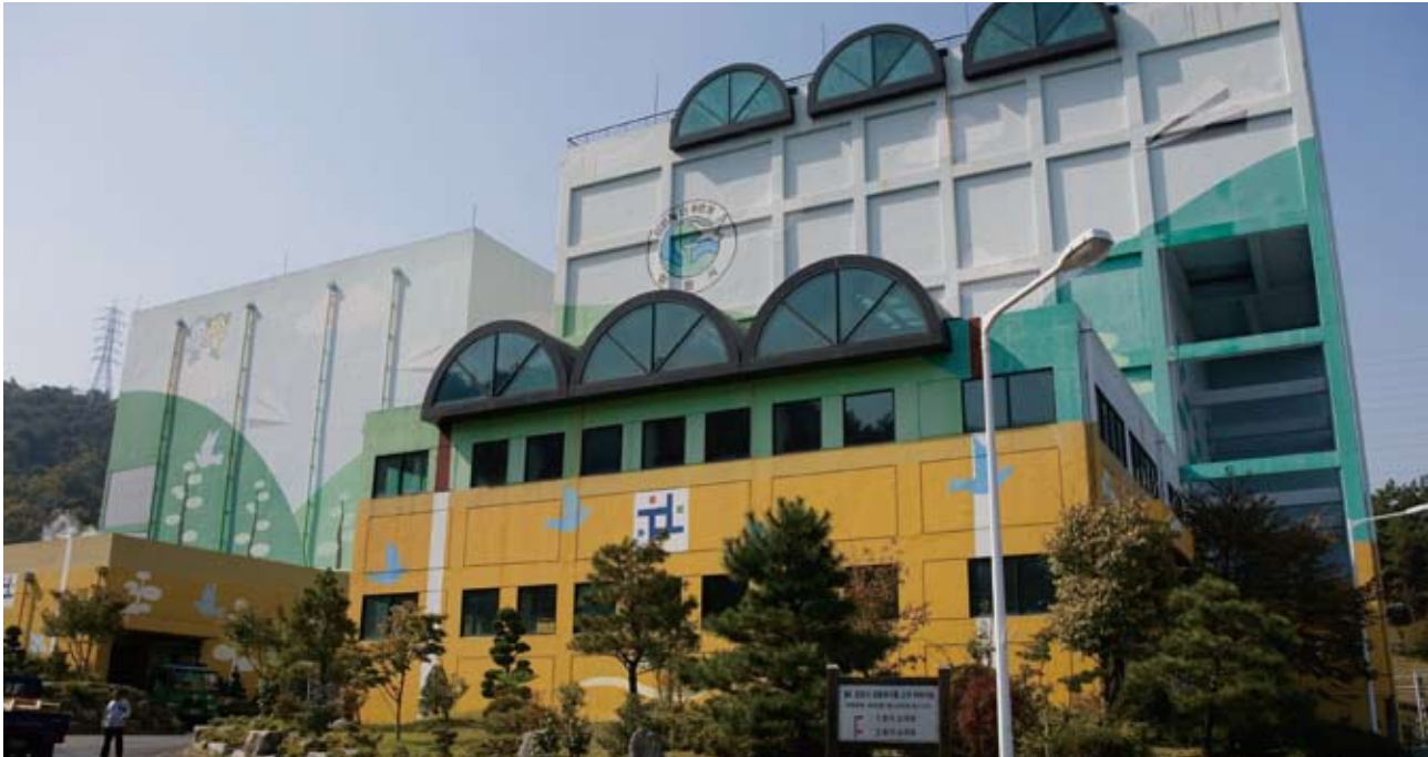
▲창원시와 마산시가 공동 사용하는 창원시 생활폐기물 소각장
