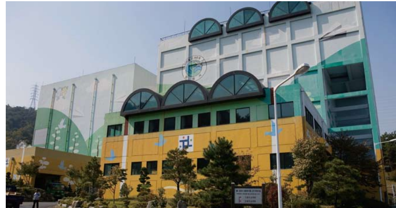
▲창원시와 마산시가 공동 사용하는 창원시 생활폐기물 소각장
