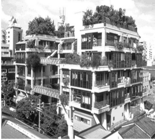
오사카 'NEXT21' 주택
