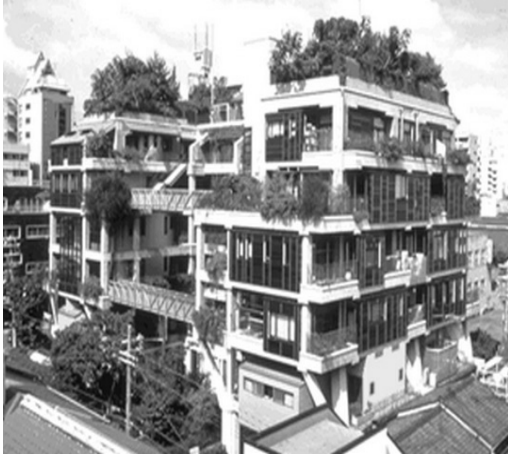
오사카 'NEXT21' 주택
