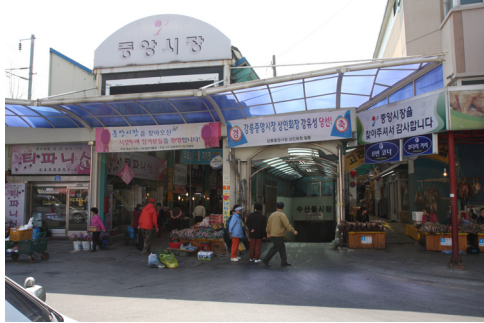
<그림 IV-1> 강릉 중앙시장 전경
