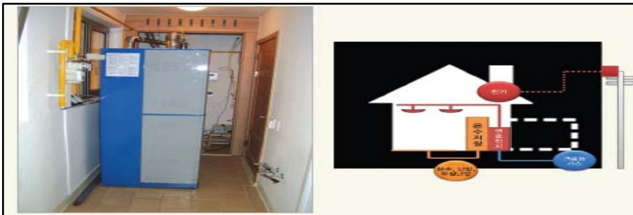
(그림10) 연료전지 시스템의 설치 및 구성도
