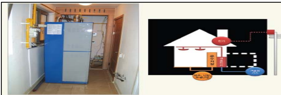
(그림10) 연료전지 시스템의 설치 및 구성도
