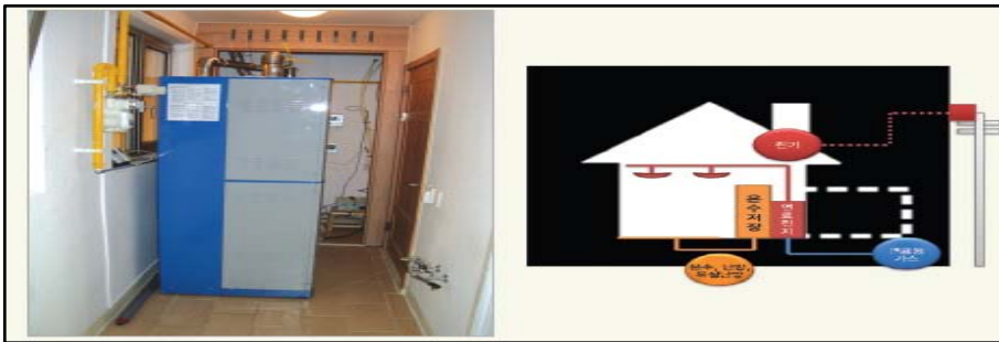
(그림10) 연료전지 시스템의 설치 및 구성도
