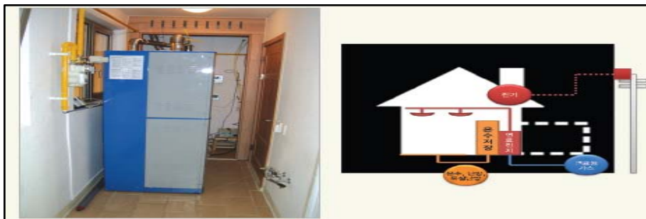
(그림10) 연료전지 시스템의 설치 및 구성도
