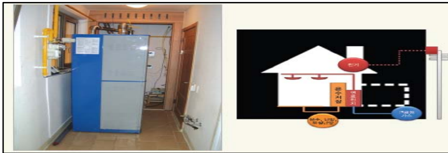
(그림10) 연료전지 시스템의 설치 및 구성도
