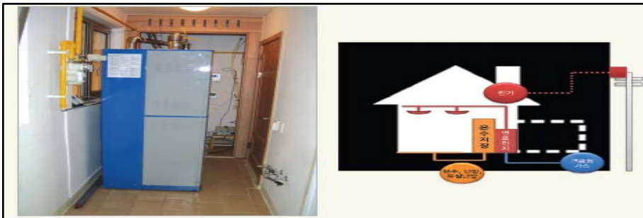
(그림10) 연료전지 시스템의 설치 및 구성도
