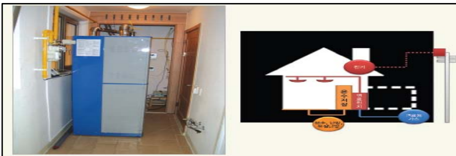
(그림10) 연료전지 시스템의 설치 및 구성도
