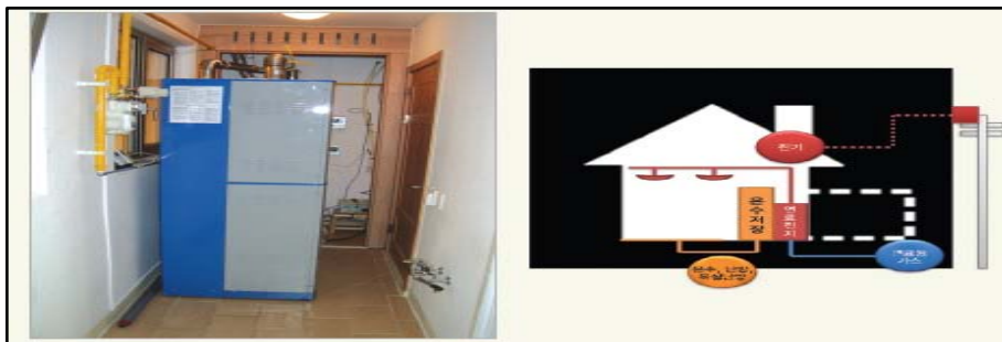
(그림10) 연료전지 시스템의 설치 및 구성도
