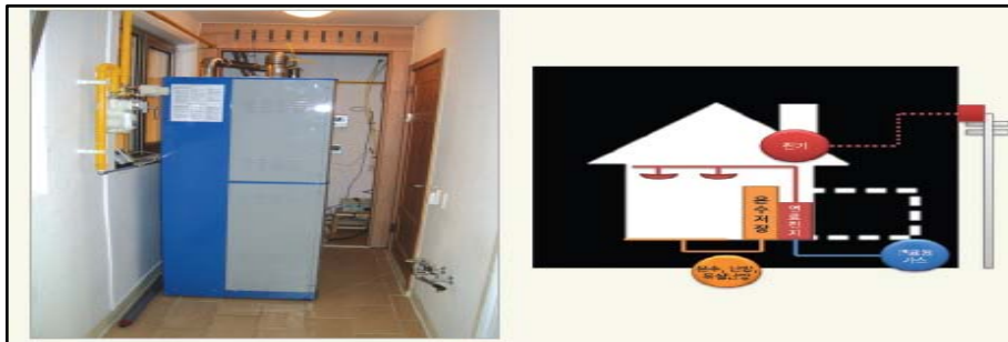
(그림10) 연료전지 시스템의 설치 및 구성도
