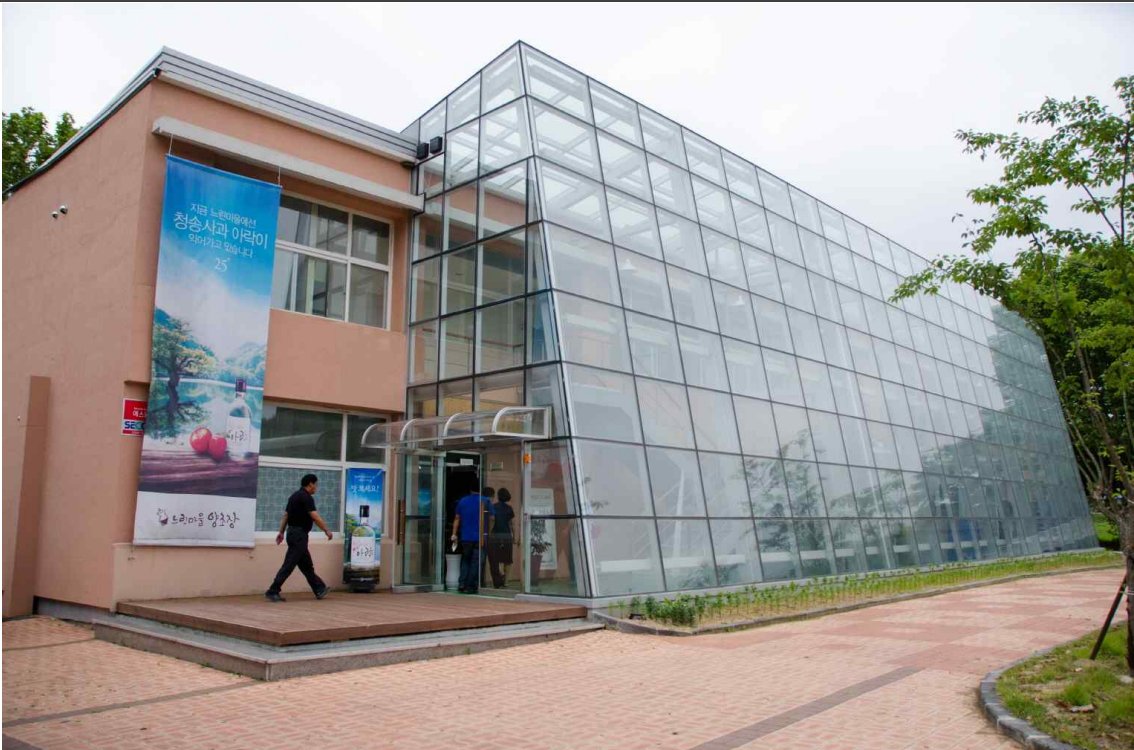
▣ 특화현장 청송양원(청송사과를 원료로 한 증류주 “청송아락” 제조) 전경
