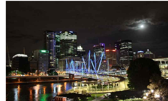
Xbc fY Kurilpa 교량에 설치된 태양광 시설
